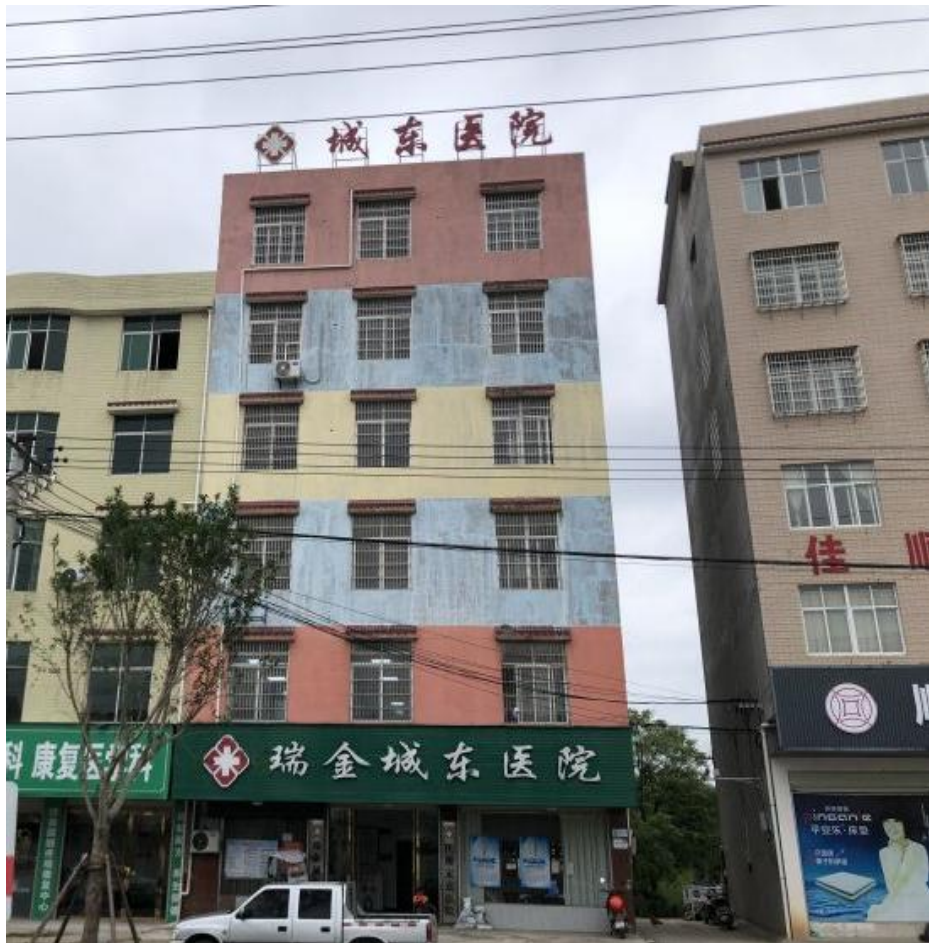
附图9 项目现场照片
